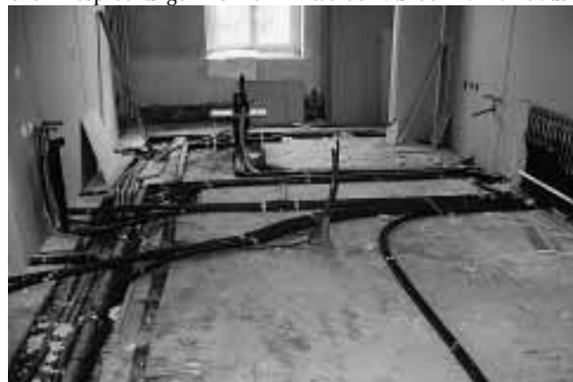
Das «Innenleben» einer im Entstehen begriffenen Zahnarztpraxis – alles klar?
